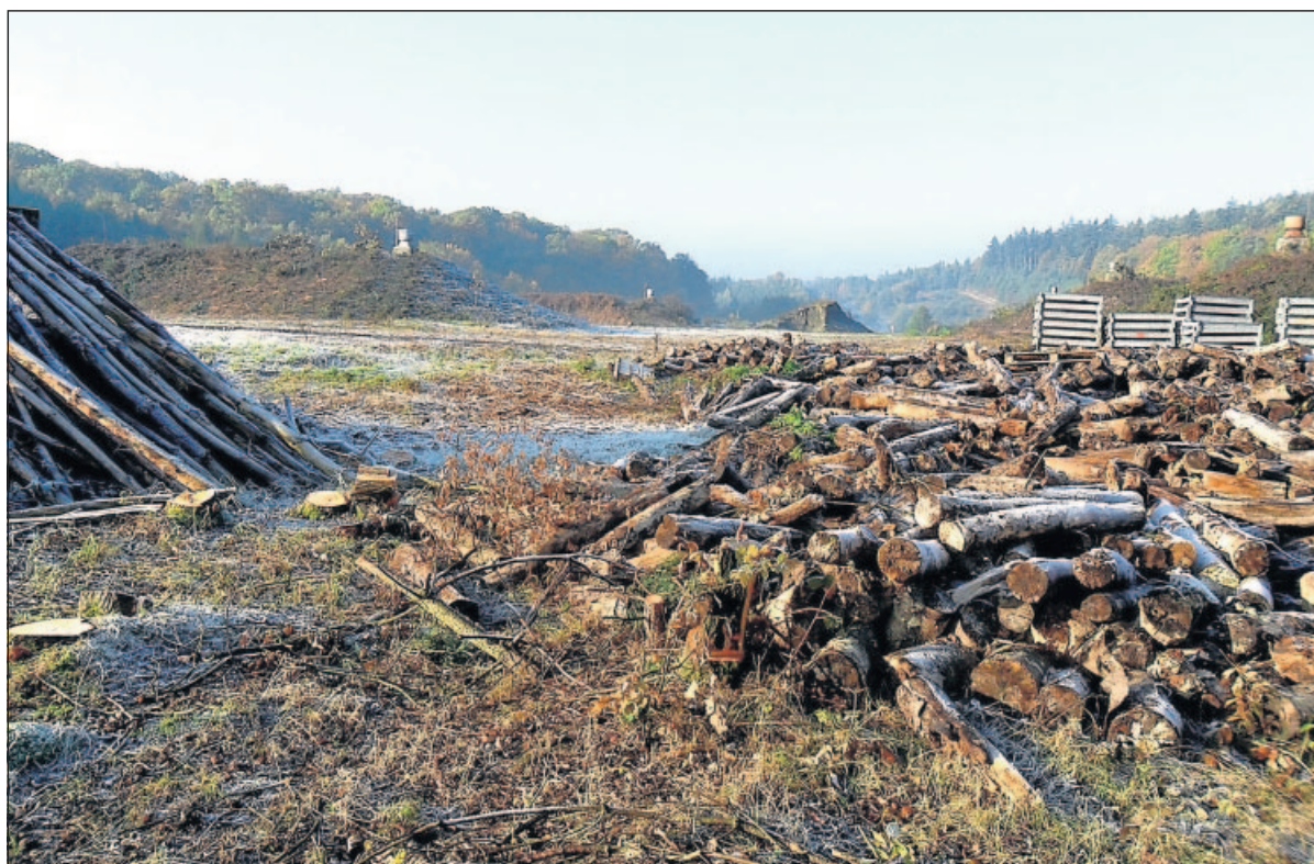
Die Sonne zeigte sich am Samstag erst zögerlich, dann aber kraftvoll über dem bereits gerodeten Areal, auf dem der Solarpark Clausen entstehen soll.
