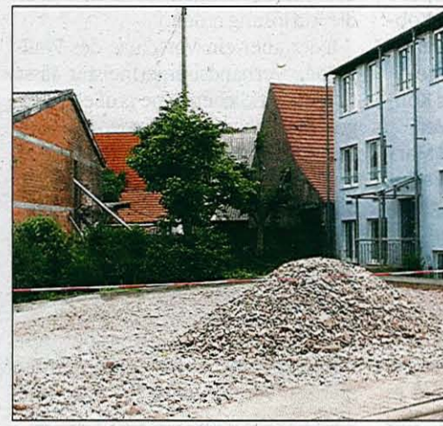
Nach der Beseitigung des ehemaligen Hirtegemeinschaftshaus samt Feuerwehrunterkriegen Großteil des freigewordenen Grundstücks als Parkfläche ausbauen. (Foto: L. F)
